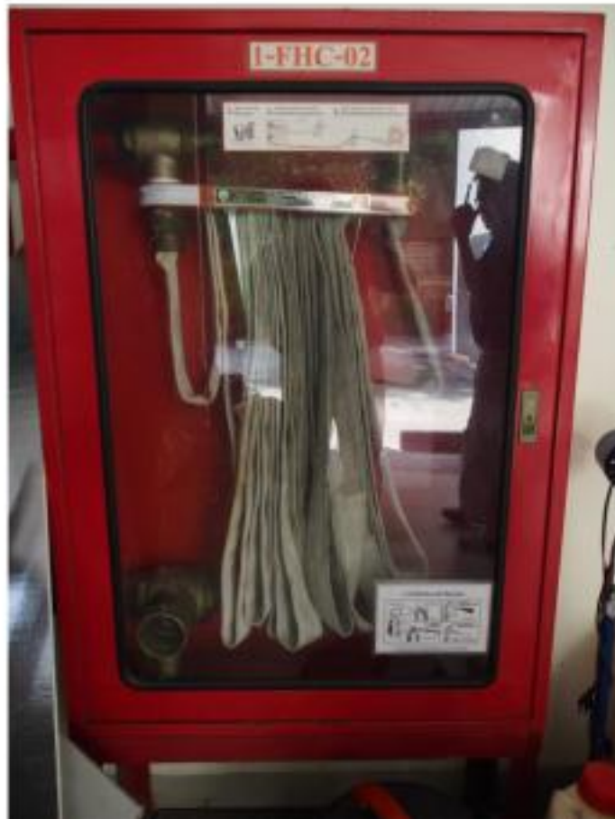
ภาพที่21 แสดงตู้เก็บสายดับเพลิง
