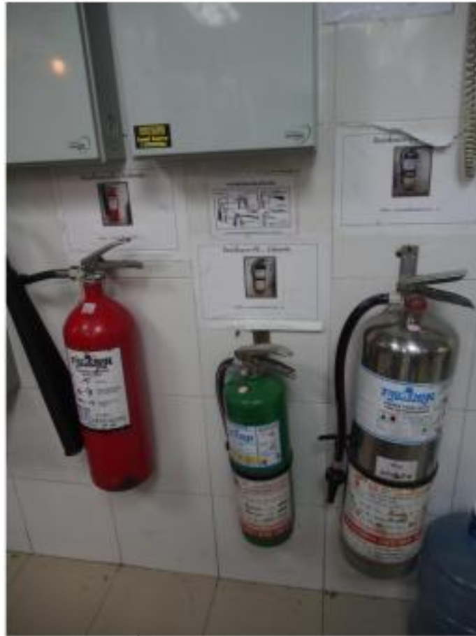
ภาพที่23 แสดงถังดับเพลิงชนิดเคมีผงแห้ง
