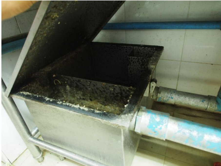
ภาพที่5 แสดงถังดักไขมันเบื้องต้นภายในห้องครัว
