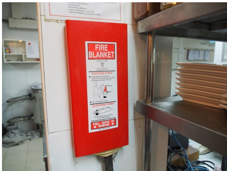
ภาพที่22 แสดงผ้ากันไฟ Fire Blanket
